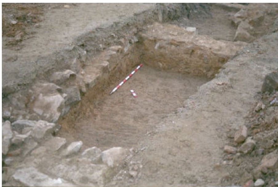
Foto 35. Rasa 3. Murs u.e: 129, 167 i 168.
