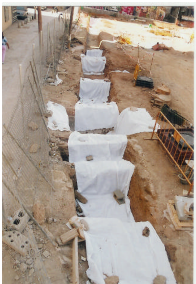
Foto 73. Vista general del cobriment d’estructures del Solar Pou de la Figuera.
